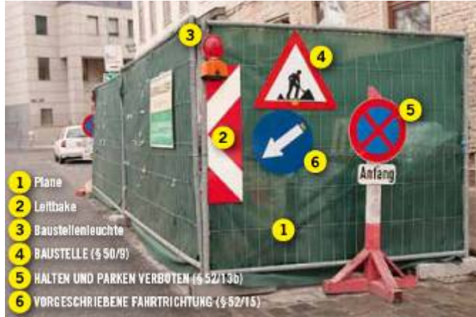
Abbildung 1: Zu einer korrekten Baustelleneinrichtung gehören eine Pläne, ein Leitbake, eine Baustellenleuchte, ein Gefahrenzeichen „Baustelle“, ein Vorschriftenzeichen „Halten und Parken verboten“ sowie ein Hinweiszeichen für die vorgeschriebene Fahrtrichtung.
