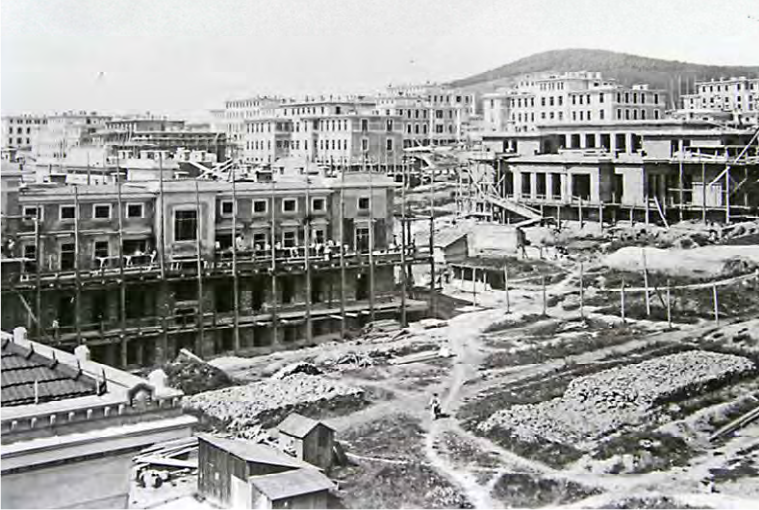
Steinhof – Baustelle im Überblick ca. 1906
