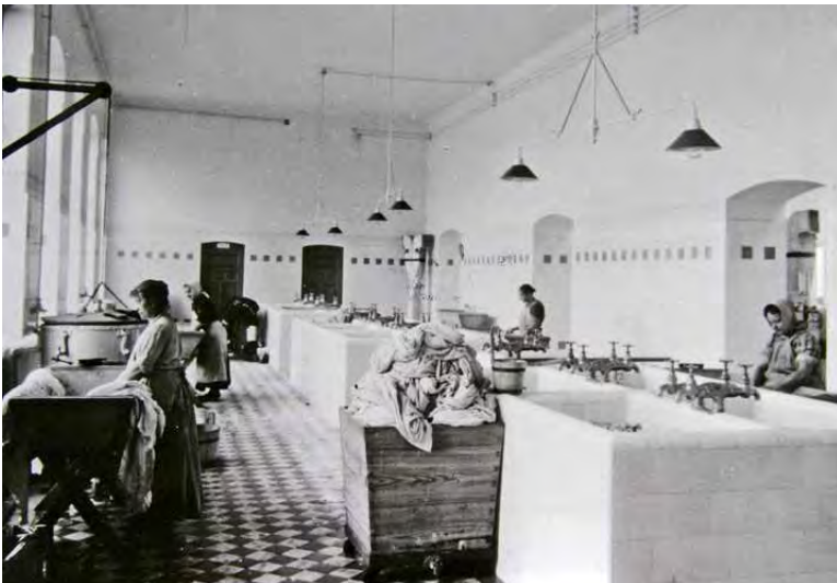
Für Patientinnen gab es die (gleichfalls Therapie-) Möglichkeit, in der Wäscherei zu arbeiten. Daneben befand sich außerdem eine Näherei, in welcher Bettzeug hergestellt oder geflickt wurde.
