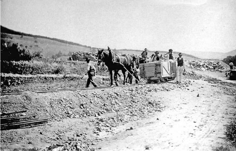
Bauarbeiten wurden durch Schienen und Pferdewagen erleichtert
