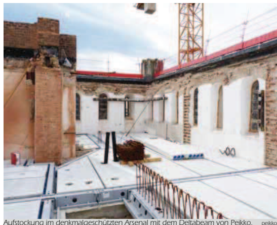
Aufstockung im denkmalgeschützten Arsenal mit dem Deltabeam von Peikko. peikko
