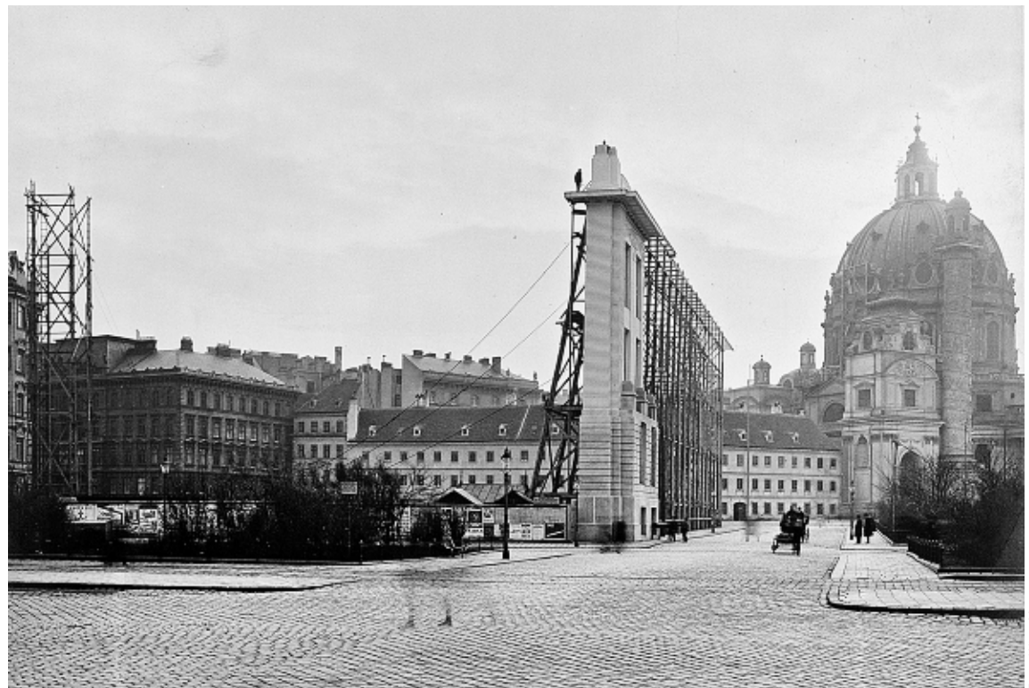
Neubau des Wien-Museums von Otto Wagner am Karlsplatz: Im Jänner 1910 sollte eine „Schablone“, ein Eins-zu-eins-Modell, für eine Auftragserteilung sorgen, stattdessen wurde das Projekt fallengelassen.
