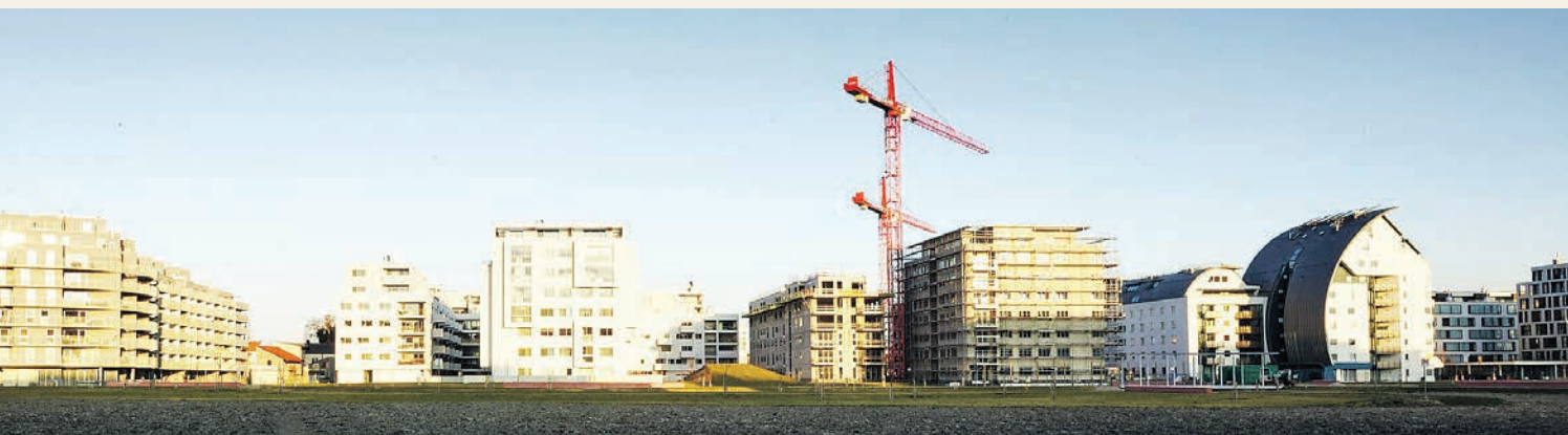
In der Donaustadt befindet sich das größte Entwicklungsgebiet Wiens: die Seestadt Aspern. Aber auch an vielen anderen Ecken wird dort gebaut – hier etwa in der Tokiostraße (Wien 22)
