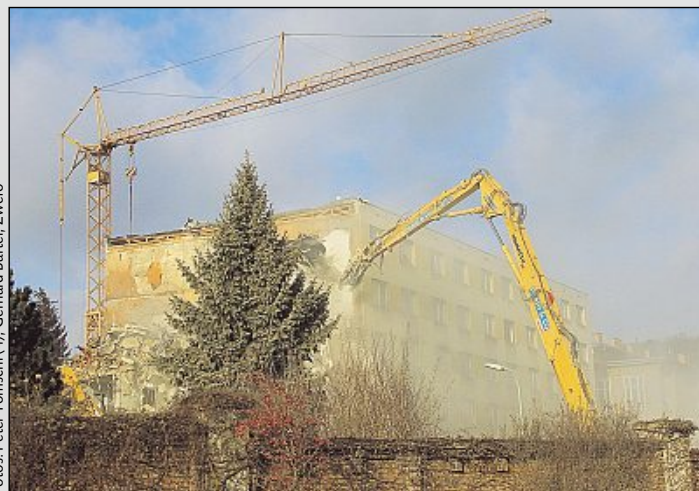
Im Sommer 2011 kam es zu ersten Abriss- und Bauarbeiten
